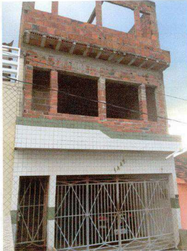
FOTO 01: Frente do imóvel
