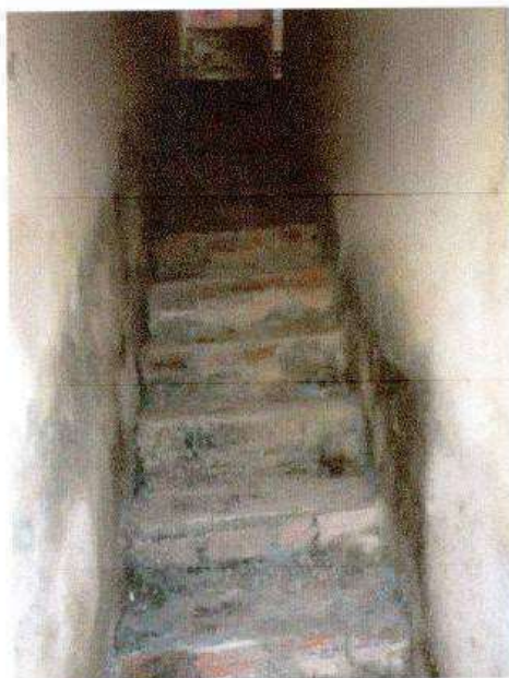
FOTO 16: Escada de acesso ao 1º pavimento
