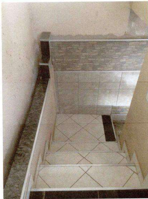
FOTO 12: Escada de acesso a piscina e área de lazer
